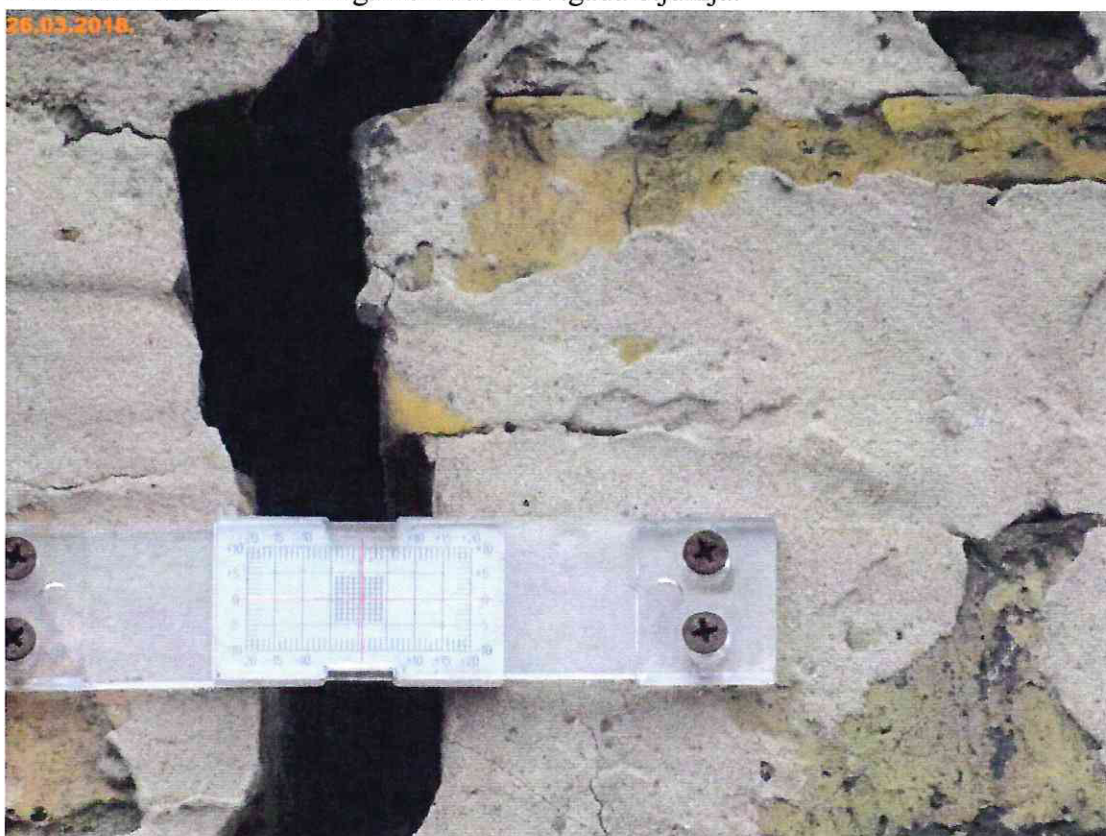
18.attēls. Plaisas monitoringa noniuss 2018.gada 26.martā.
