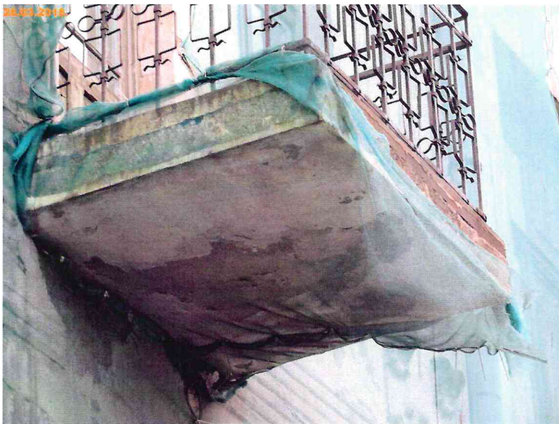
13.attēls. Ēkas Kuģinieku ielā 2, Ventspilī balkons.
