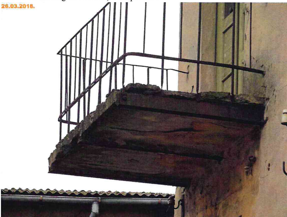
14.attēls. Ēkas Kuģinieku ielā 2, Ventspilī balkons.
