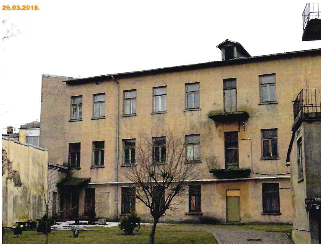
7.attēls. Ēkas Pils ielā 38, Ventspilī pagalma puses fasāde.
