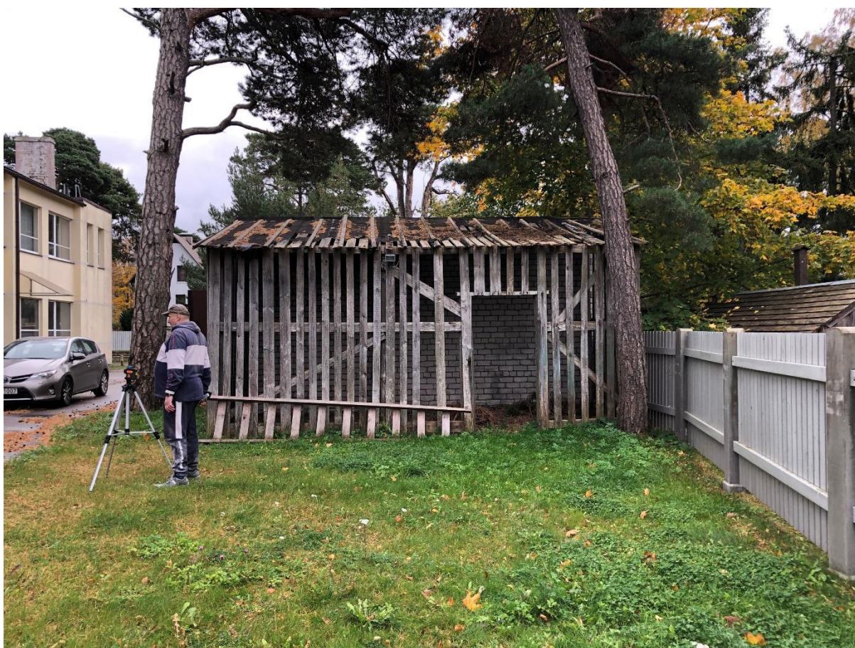
10. att. Šķūņa ēka
