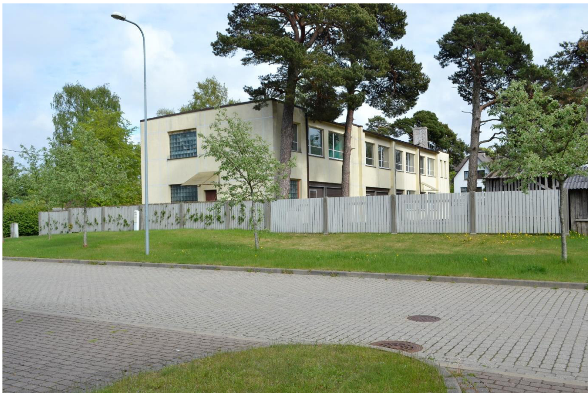
6. att. Administratīvās ēka, skats no Jūrmalas ielas
