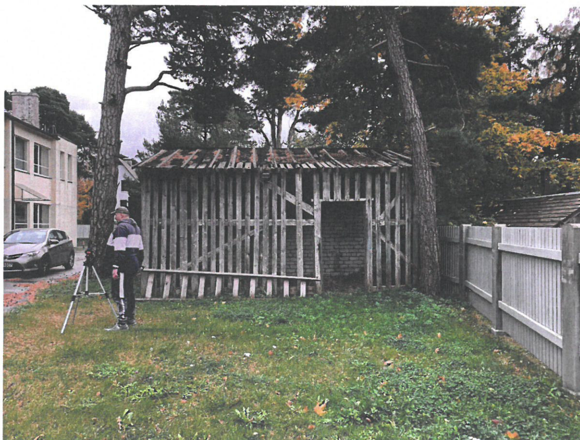
10. att. Šķūņa ēka
