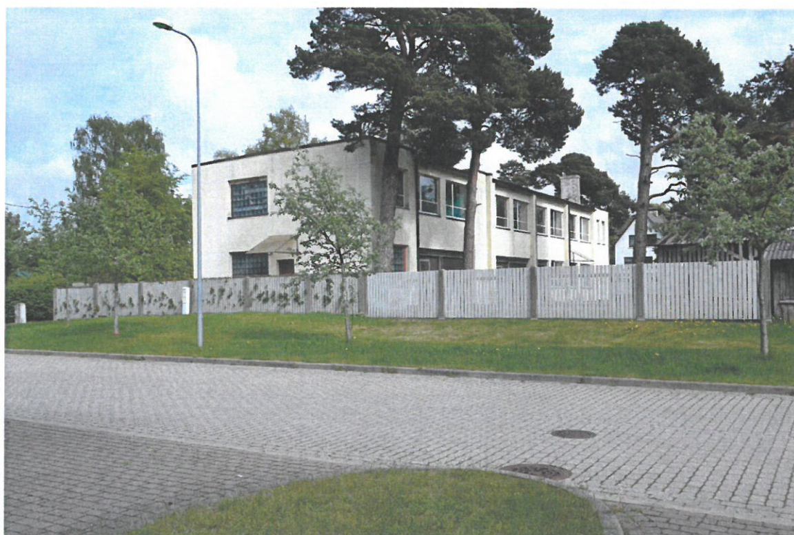
6. att. Administratīvās ēka, skats no Jūrmalas ielas
