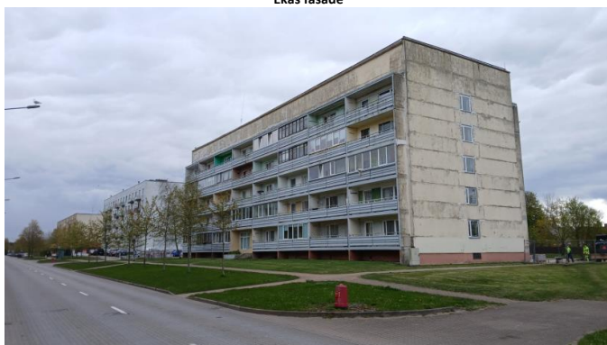
Ieeja kāpņu telpā, kāpņu telpa un gaitenis
