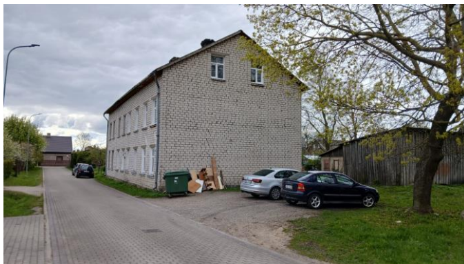
Daudzdzīvokļu ēkas fasāde
